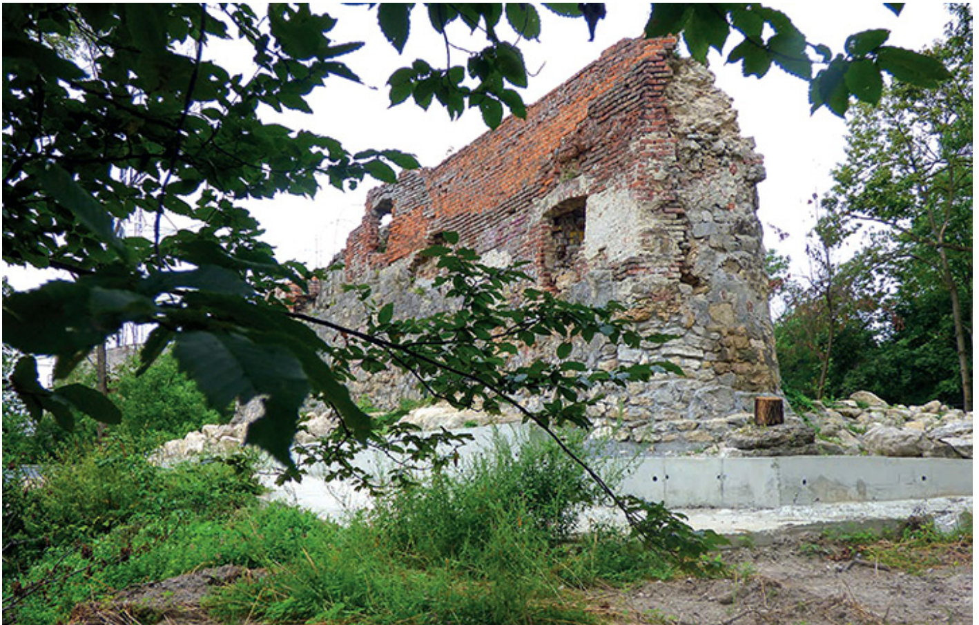
Ruiny murów obronnych Wysokiego Zamku
