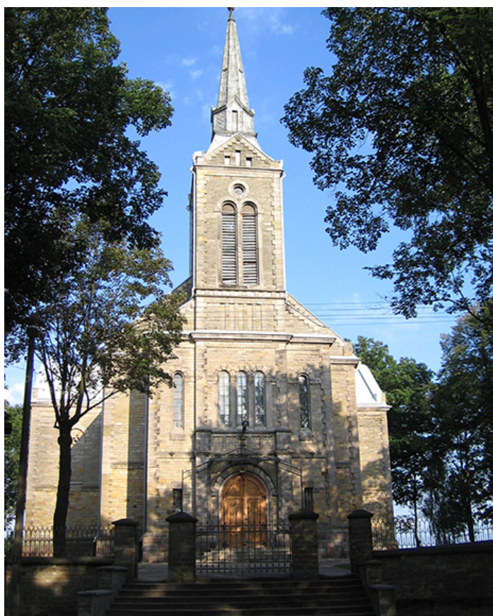
Kościół w Kraśnicy, fot. arch. autorki
