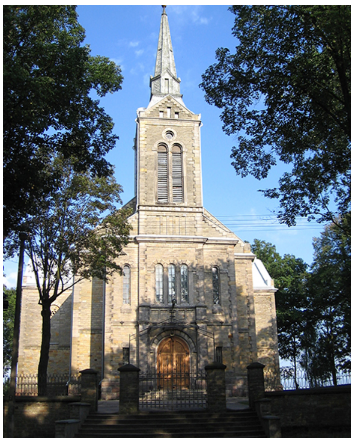
Kościół w Kraśnicy, fot. arch. autorki
