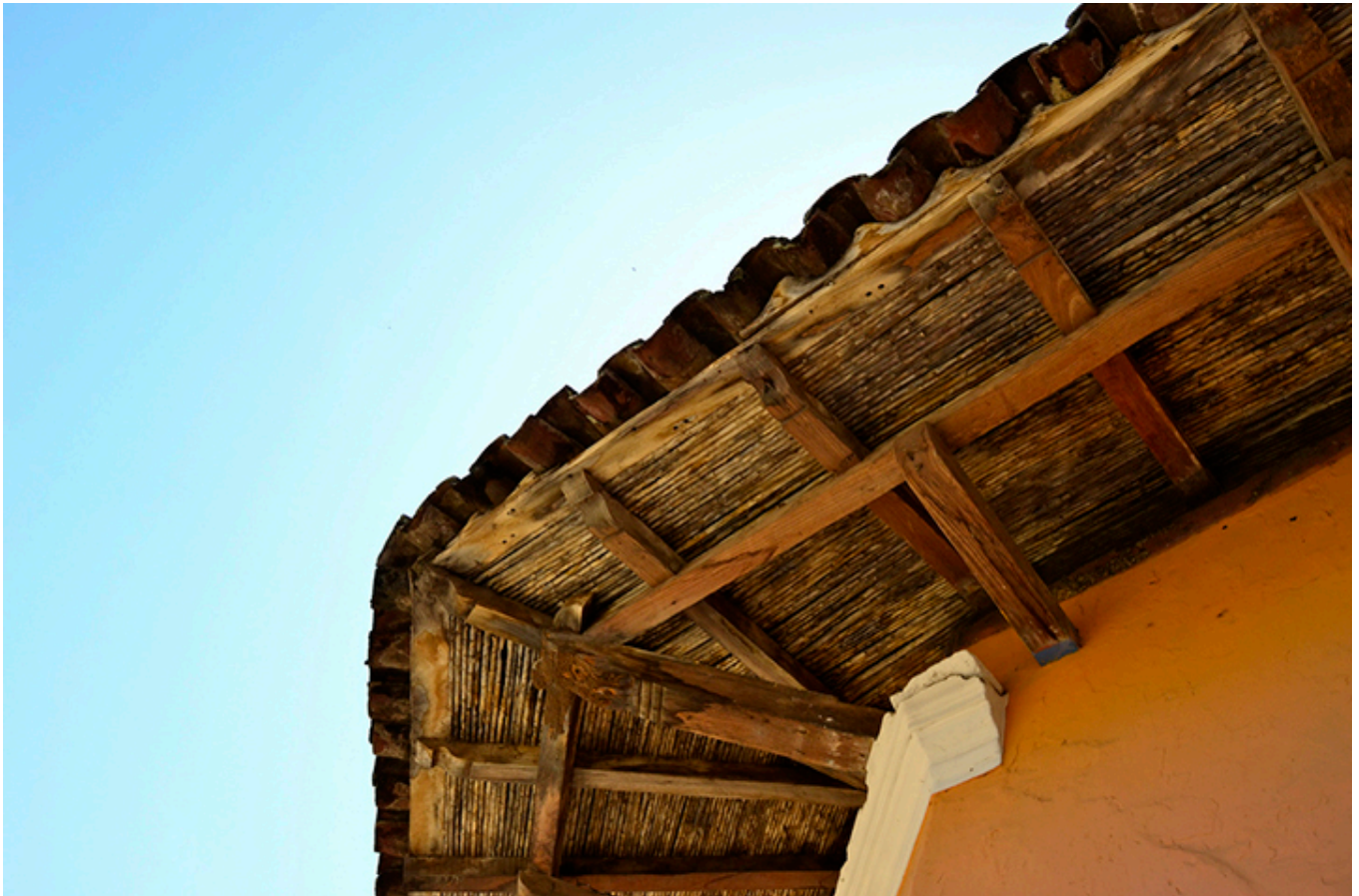
Granada. Wysunięty narożny okap dachu.
