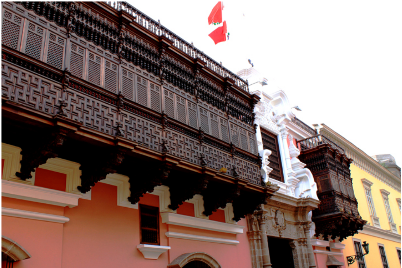
Lima. Balkony na fasadzie Pałacu Torre Tagle.
