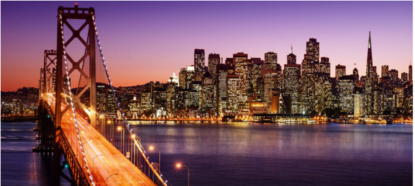
Bay Bridge i widok na San Francisco.
