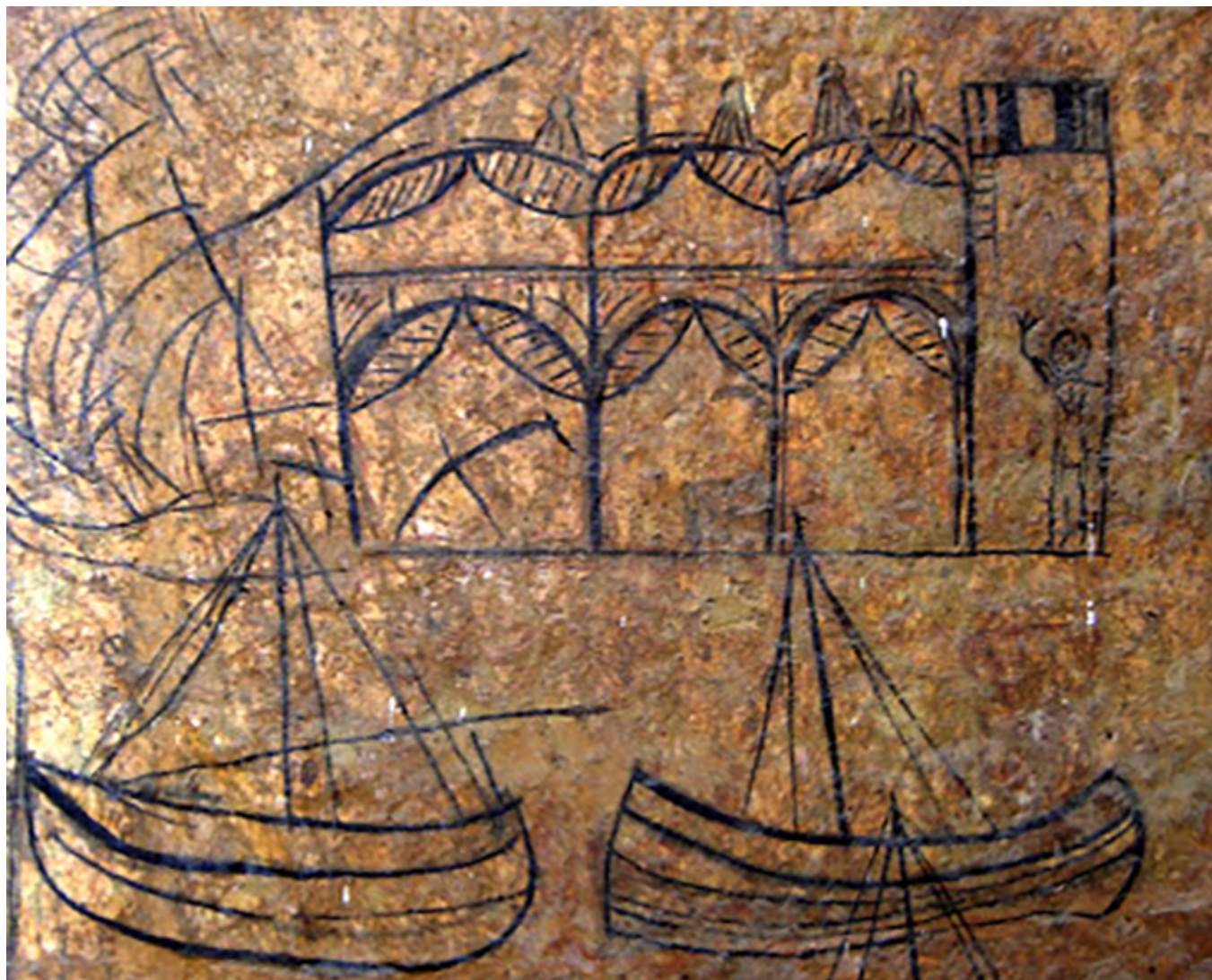
Fort Jezusa. Rysunki na ścianach.
